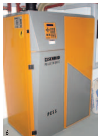
Holzfeuerungen bieten nachhaltige Technologie und diverse Einsatzmöglichkeiten. Durch Schmid realisiert wurden unter anderem auch diese Anlagen in Winterthur-Sennhof (Bild 5, Typ Vorschubrost UTSR-700.3, Leistung 700 kW, Brennstoff: Schnitzel, Contracting mit Städtischen Werken), in einem Einfamilienhaus (Bild 6, Typ Pelletronic PESS-25, Leistung 25 kW, Brennstoff: Pellets) und in Chile (Bild 7, Typ 2 x UTSR-20000, Leistung 40 MW, Brennstoff: Rinde, Sägemehl und Schnitzel).
