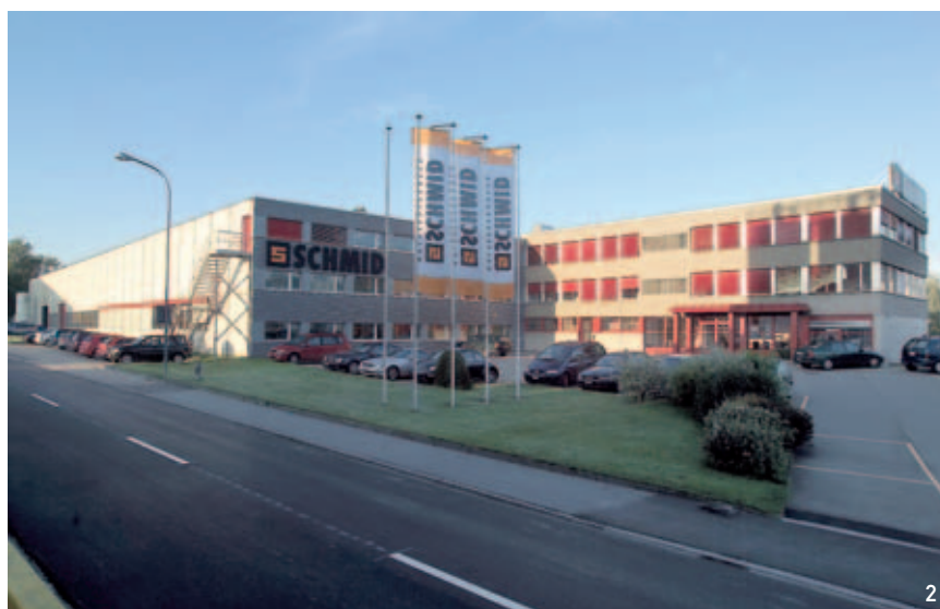
Hauptsitz der Schmid AG, Holzfeuerungen in Eschlikon (TG): Das Unternehmen ist führender Schweizer Hersteller von Holzfeuerungen, prägt deren technische Entwicklung seit Jahrzehnten und ist heute weit über die Landesgrenzen hinaus aktiv.
