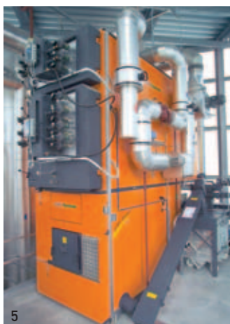
Holzfeuerungen bieten nachhaltige Technologie und diverse Einsatzmöglichkeiten. Durch Schmid realisiert wurden unter anderem auch diese Anlagen in Winterthur-Sennhof (Bild 5, Typ Vorschubrost UTSR-700.3, Leistung 700 kW, Brennstoff: Schnitzel, Contracting mit Städtischen Werken), in einem Einfamilienhaus (Bild 6, Typ Pelletronic PESS-25, Leistung 25 kW, Brennstoff: Pellets) und in Chile (Bild 7, Typ 2 x UTSR-20000, Leistung 40 MW, Brennstoff: Rinde, Sägemehl und Schnitzel).
