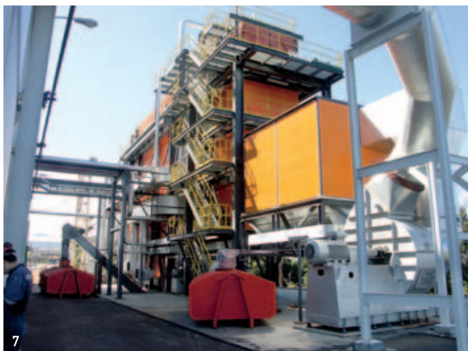
Holzfeuerungen bieten nachhaltige Technologie und diverse Einsatzmöglichkeiten. Durch Schmid realisiert wurden unter anderem auch diese Anlagen in Winterthur-Sennhof (Bild 5, Typ Vorschubrost UTSR-700.3, Leistung 700 kW, Brennstoff: Schnitzel, Contracting mit Städtischen Werken), in einem Einfamilienhaus (Bild 6, Typ Pelletronic PESS-25, Leistung 25 kW, Brennstoff: Pellets) und in Chile (Bild 7, Typ 2 x UTSR-20000, Leistung 40 MW, Brennstoff: Rinde, Sägemehl und Schnitzel).
